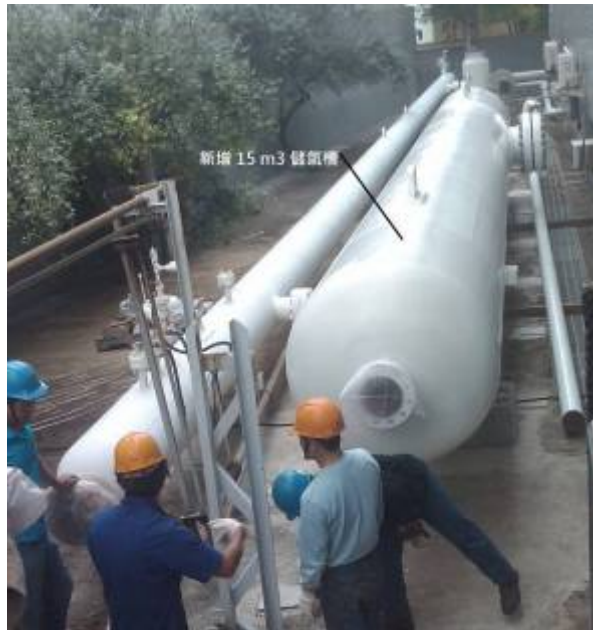
圖 2-19、儲氣槽安裝照片
