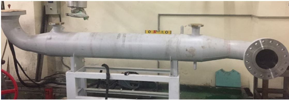
圖 1-7b、鼓風機管線之熱交換器
