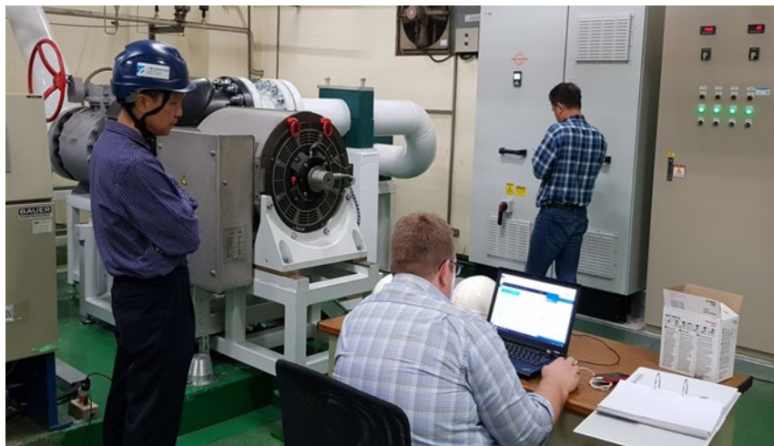
圖 1-25、德國工程師至現場配合進行安裝測試與人員訓練照片
