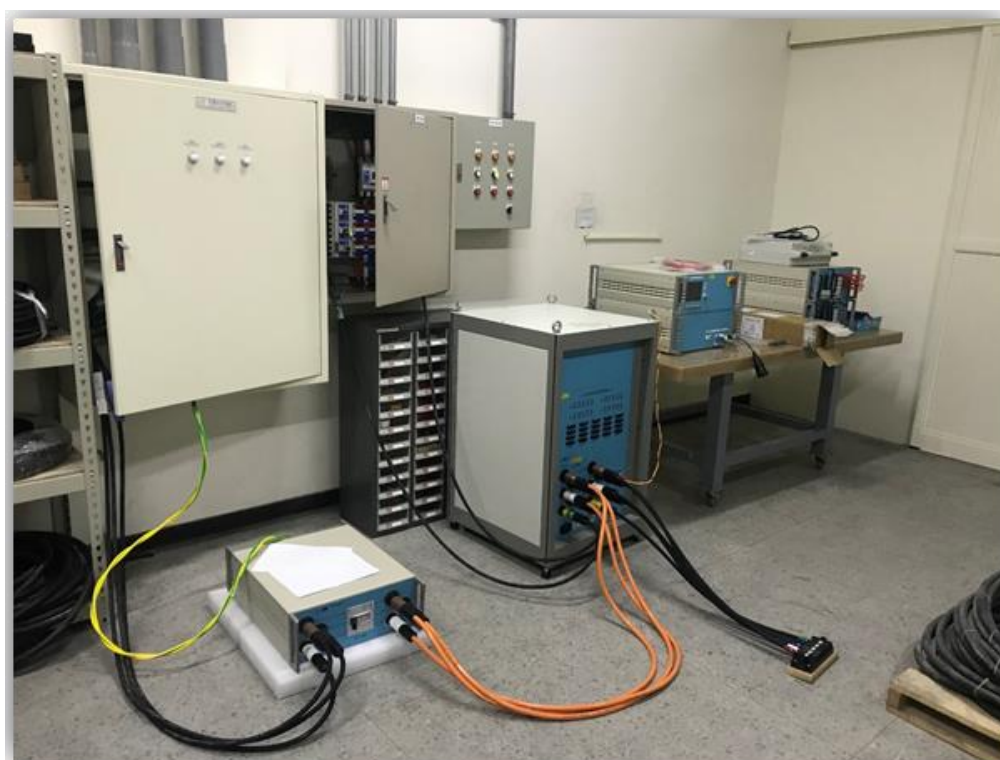
圖 26、智慧變流器電磁相容量測設備實際照片
